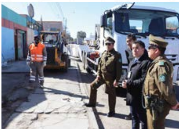
Demolición inmueble Quetena con Ramírez
