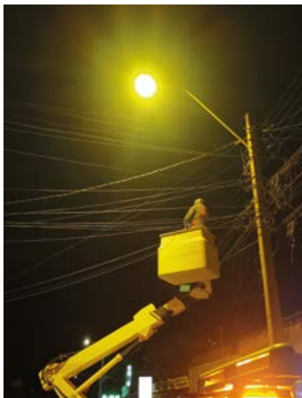
Reposicion de Luminarias
